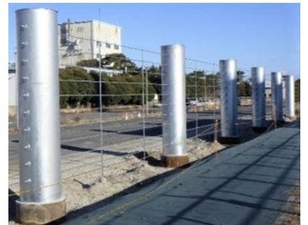
安全対策工事として実施した津波漂流物防護柵の設置工事
