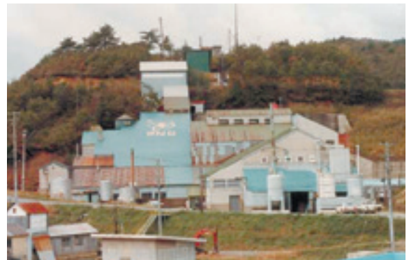
昭和40年代に建設された試験製錬所
