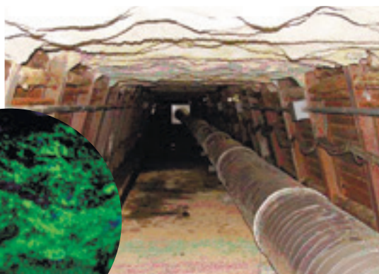
坑道内の様子
