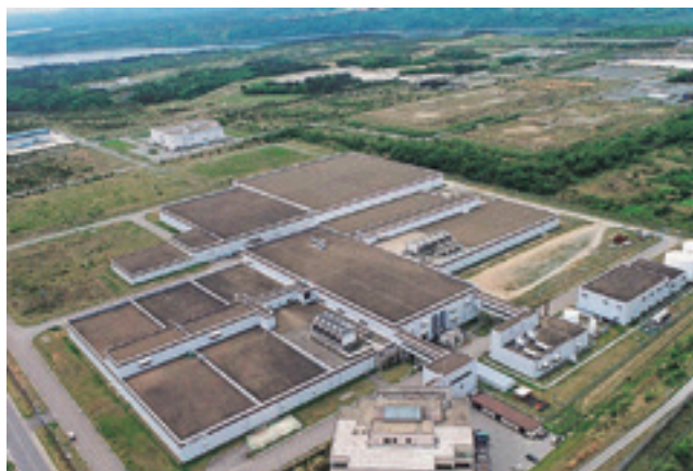
日本原燃(株)ウラン濃縮工場
