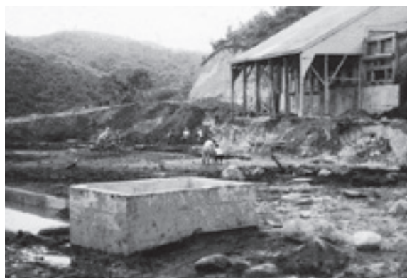
試験製錬所建設中の様子
