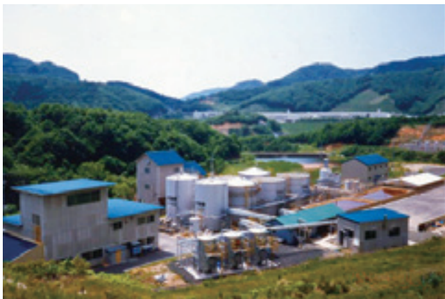
昭和60年代に建設されたヒープリーチング試験設備
