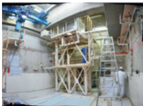
製錬転換施設の主要設備の解体の様子
