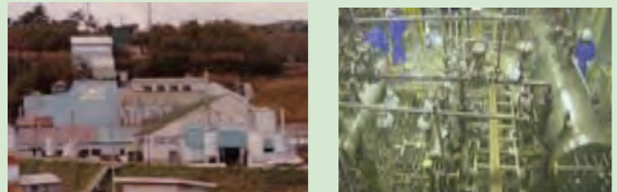
旧製錬所及び製錬転換施設内部の状況
