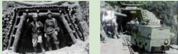
ウラン探鉱用の坑道入口の状況
