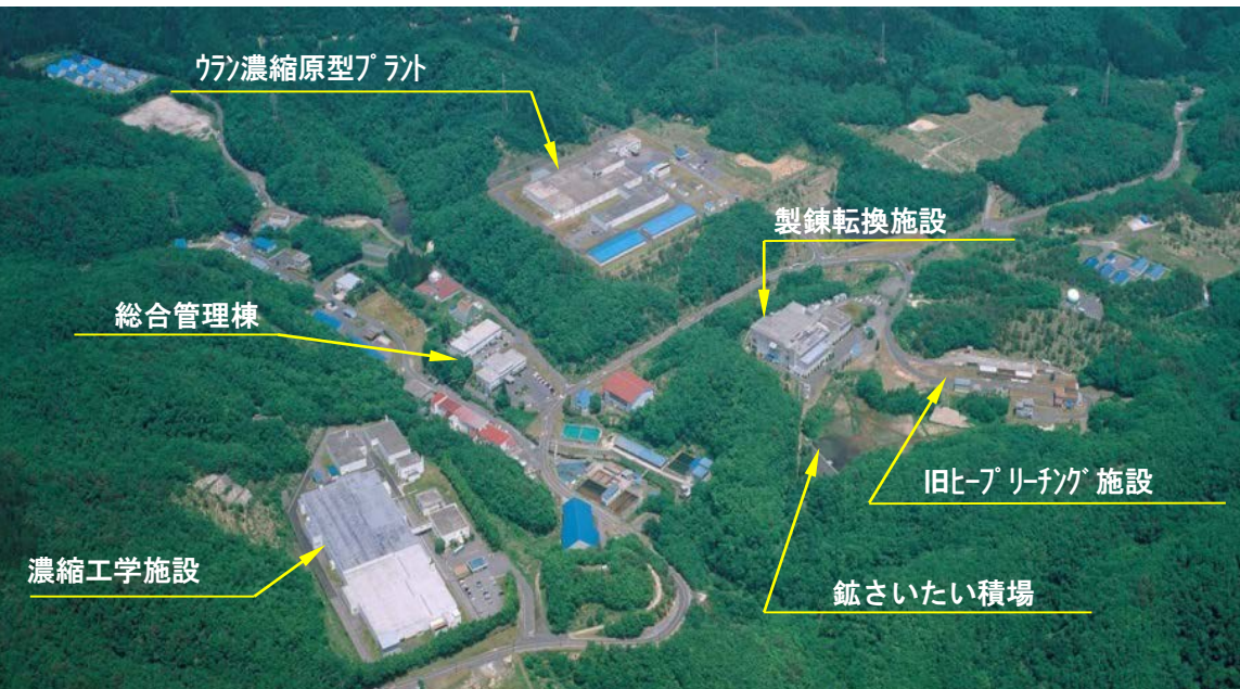
人形峠環境技術センター全景と主な施設
