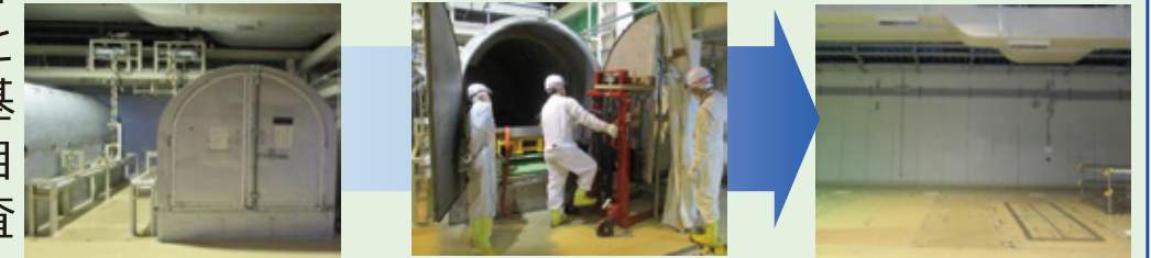
設備解体前後の状況
