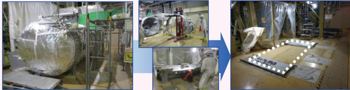
令和5年度に実施したウラン濃縮原型プラントにおける設備解体前後の状況
