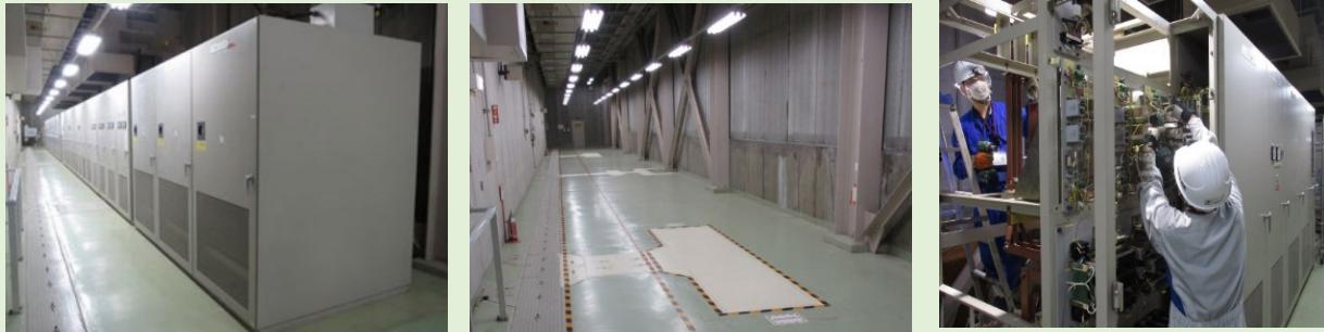
DOP-1 運転単位・高周波電源室の設備解体前（左）と解体撤去後（中）、盤内装品撤去の様子（右）
