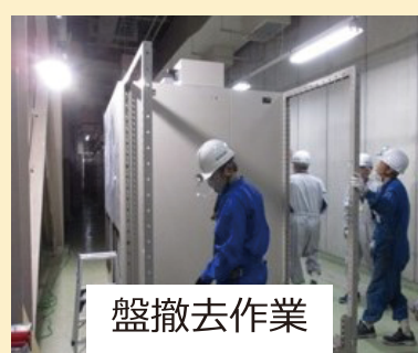
DOP-1（第1運転単位） 高周波電源設備の解体状況
