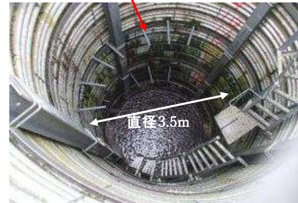
横ボーリング：100A、長さ10m仕上げ
