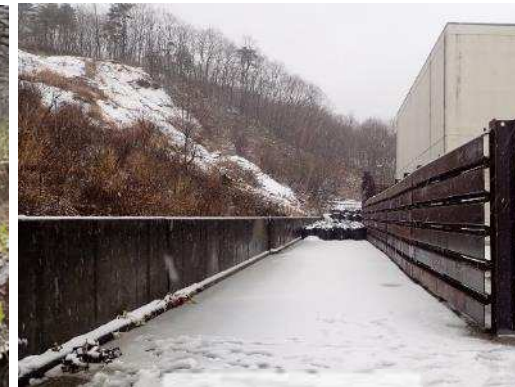
防護壁の現状
