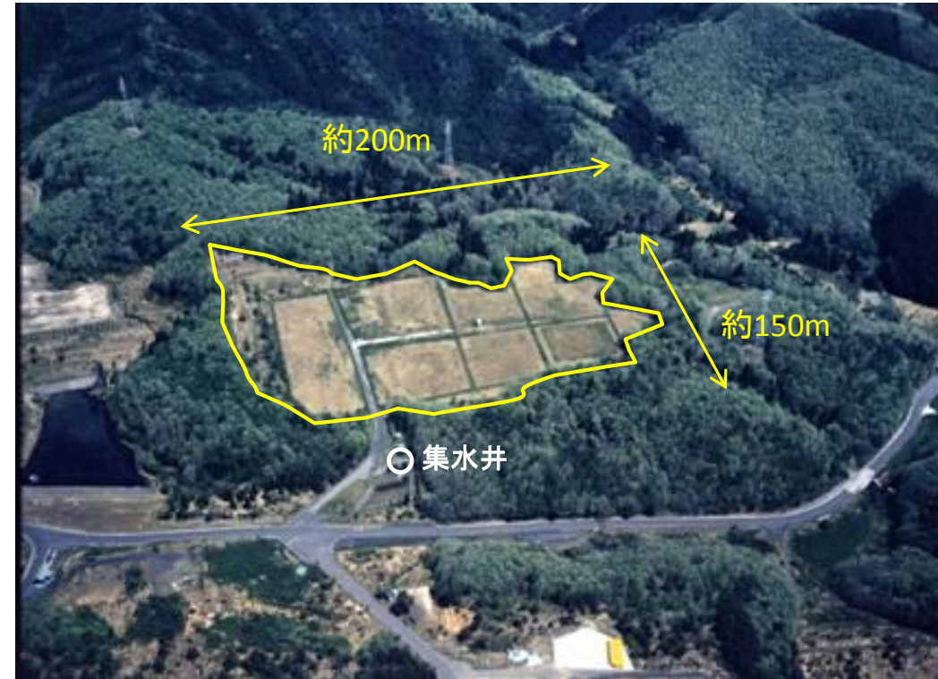
露天採掘場跡地
