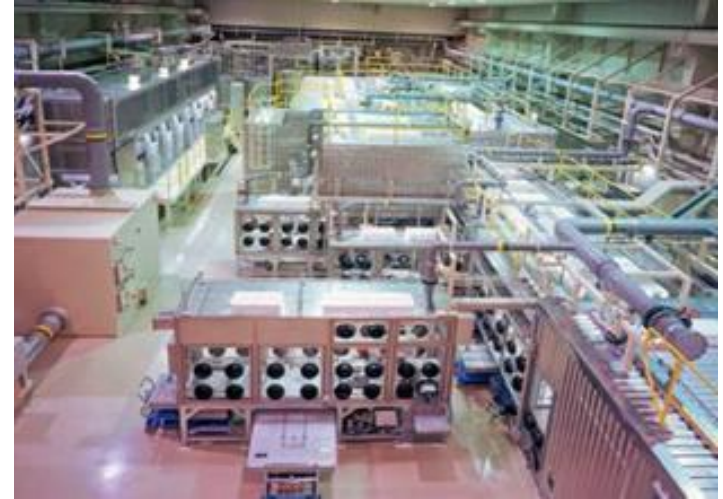
遠心機処理設備
