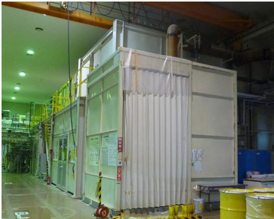
解体撤去前の設備、フード類 《濃縮工学施設 OP-1 UF 6 操作室》
