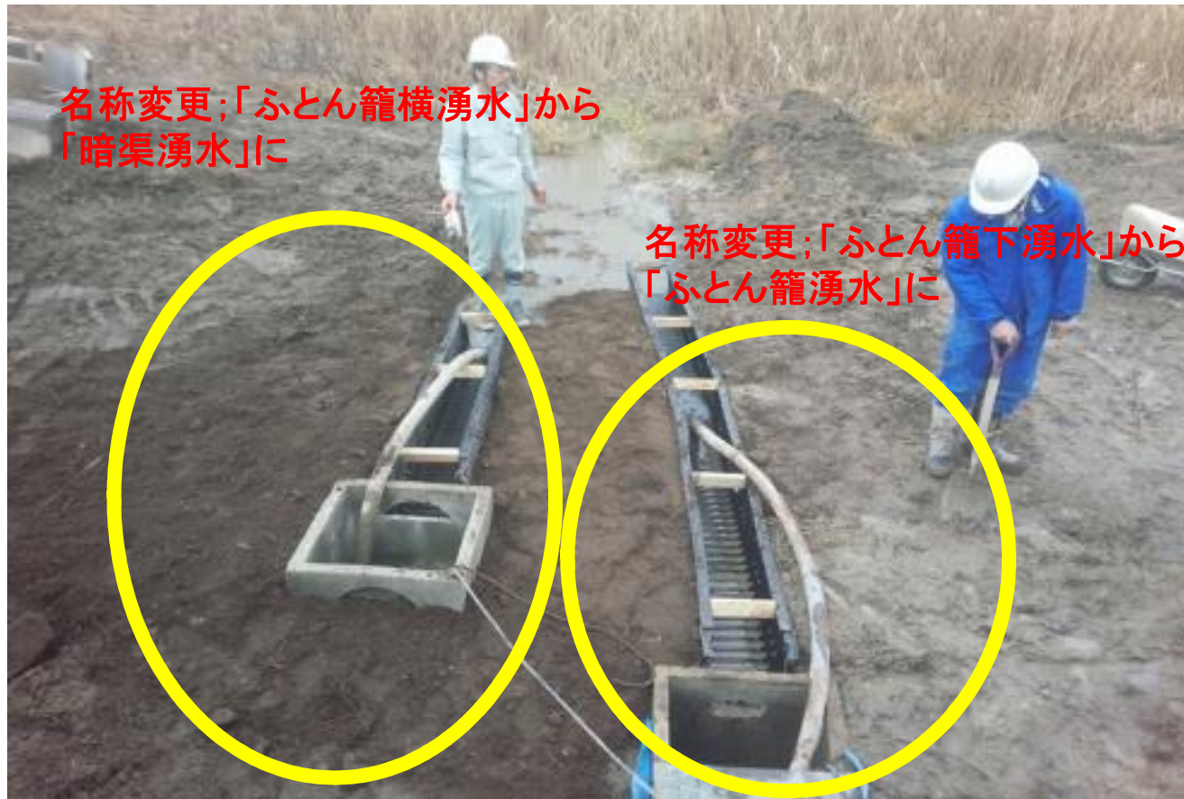
【写真2】柵設置作業を進めた(漏水対策等を後日実施)
