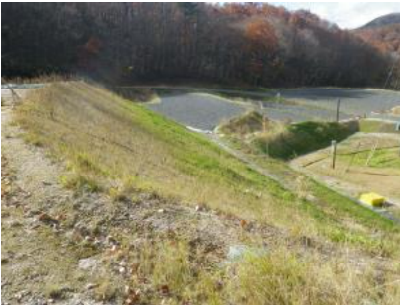
廃砂たい積場上流部から下流部方向を撮影
