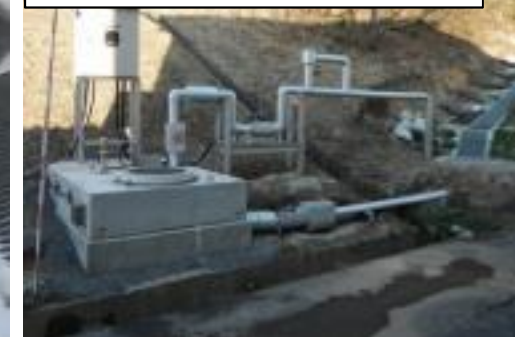
側方排水測定用のポンプピット
