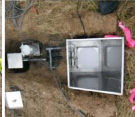
蒸発散計 (外側容器)
