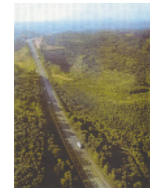
シャントループ鉱山・跡措置後
