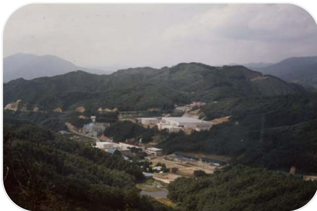
完成したパイロットプラントの遠景
