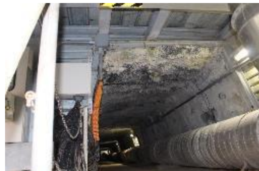
坑道に入ると鉄骨とモルタルで支えていた
