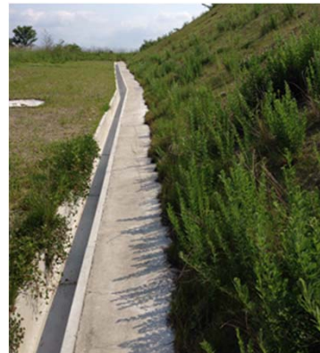
坑水の発生源対策の例(秋田県小真木鉱山)
