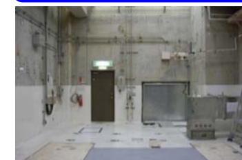
設備を撤去 した製錬転 換施設
