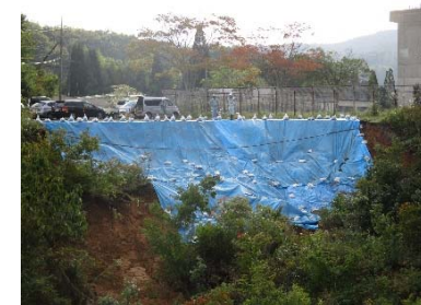
崩落部の養生措置
