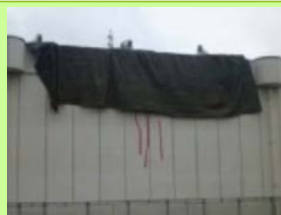
外壁の破損を想定した養生訓練
