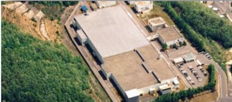
研究開発を終了した設備の解体
