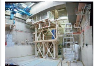
製錬転換設備の解体状況
