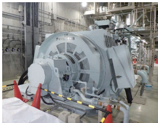
解体前のディーゼル発電機(写真5)
