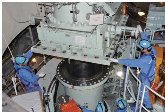
燃料交換装置の復旧(写真1)
