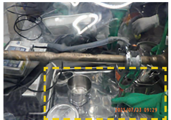
鋼製の受け皿を設置し作業を実施(写真3)
