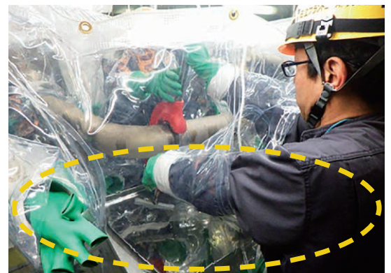
プラバグを用いた作業の様子(写真4)
