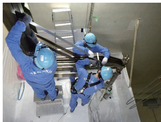
燃料交換装置の点検(写真2)
