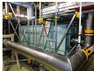
保温設備（解体前）
