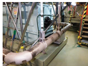
保温設備（解体後）
