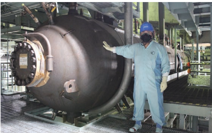
大型機器(蒸気ドラム)
