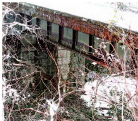
トンネルの手前にある、笙ノ川にかかる橋。石積みの橋台などは鉄道時代のものを使用しているという
