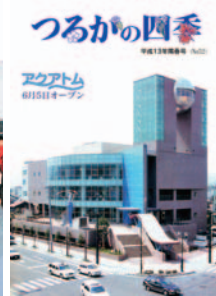
【No.52】平成13年陽春号★6月、神楽町にアクアトムがオープン
