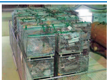
解体撤去物の一時保管状況。1m角のステンレス製のカゴに入れて、タービン建屋に保管＝今年3月撮影
