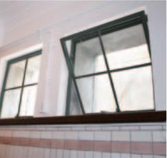
◀元レストランの窓。地上から空堀（ドライエリア）を掘り、窓から採光、換気していた。今回、埋まった空堀を掘り起こしている
