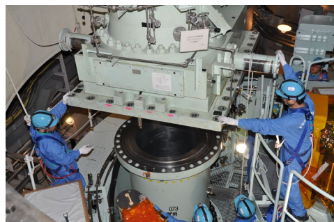
燃料交換装置の復旧
