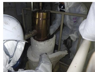
2次メンテナンス冷却系 保温設備の撤去作業
