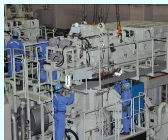
燃料出入機点検
