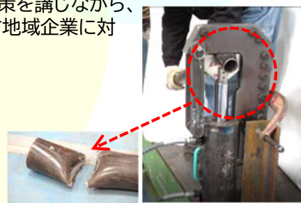
配管切断状況 油圧式切断装置 写真3 鋼管等の無火気切断装置
