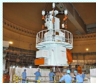
1次主冷却系循環ポンプ点検
