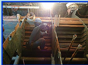
冷却管（海水管）の解体
