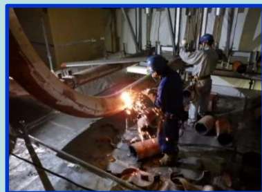
湿分分離器周辺配管の解体撤去
