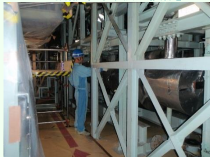
【解体作業前の 隔離冷却系熱交換器】
