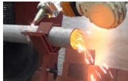
【右:模擬配管の切断風景】
