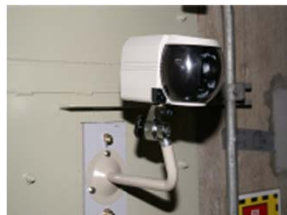
ナトリウム漏えい監視カメラ
