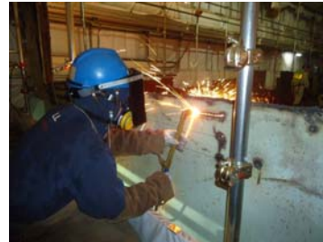
【B復水器下部胴の解体撤去作業】
