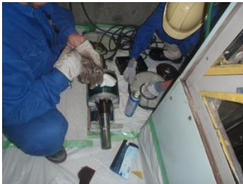
【換気空調設備ファンコイルユニット分解点検】
