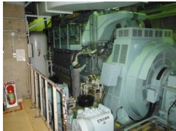
【非常用ディーゼル発電機の動作確認試験】
