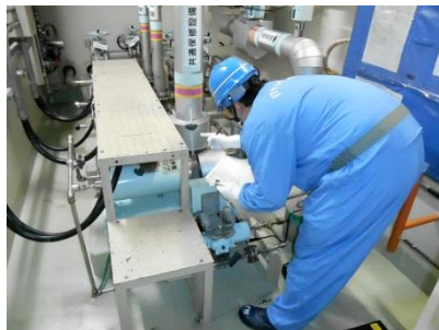
【共通保修設備 ホンプ類作動確認】 (平成26年3月12日撮影)
