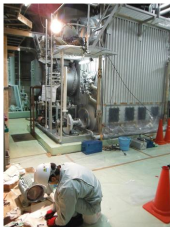
【補助ボイラーの定期点検作業】 (平成26年4月9日撮影)
