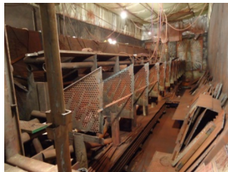
【復水器下部内部構造物の解体作業】 (平成25年12月21日撮影)
