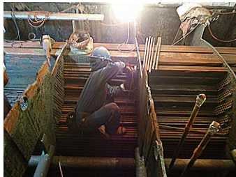
【復水器(※)冷却管の解体作業】 (平成25年11月6日撮影)
