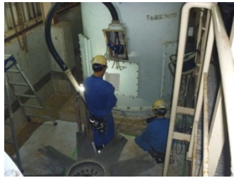
【換気空調設備 電動機分解点検作業】 (平成25年10月18日撮影)
