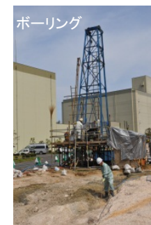
【剥ぎ取り調査状況2】 （平成25年4月29日撮影）
