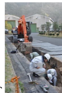
【剥ぎ取り調査状況1】 （平成24年12月13日撮影）
