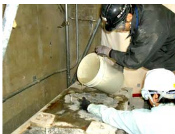
【ポンプ基礎への膨張剤注入】（撮影日：平成25年3月6日）
