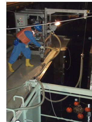
【燃料池水面清掃作業】 （撮影日：平成25年3月18日）
