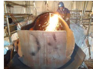
復水器(クリアランス対象物)の解体作業状況 平成25年1月撮影
