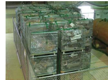
解体撤去物の一時保管状況(タービン建屋) 平成25年3月撮影
