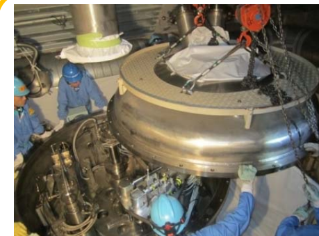
缶詰装置容器開放点検 （2017年9月～）
