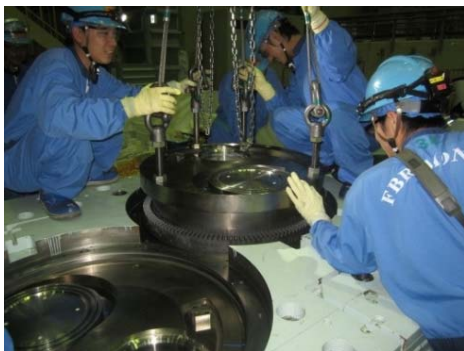
床ドアバルブ（6連式）の分解点検 （2017年7月～10月）
