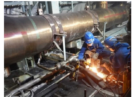
原子炉冷却系の解体作業
