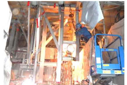
給水管の解体作業
