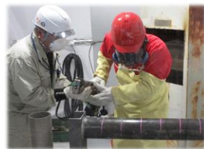
解体技術研修(2023年5月)
