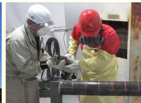
解体技術研修（2023年5月）
