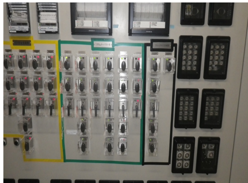
1次ナトリウムオーバフロー系(緑) メンテナンス冷却系(黒)
