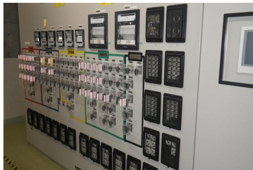
盤向かって右側から撮影
