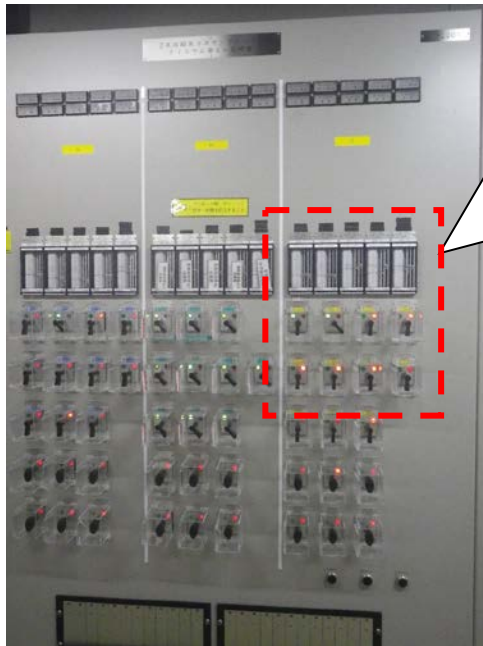
2次系CループRIDのサンプリングブロウの現場制御盤
