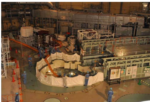
平成23年11月11日 14時頃の作業風景
